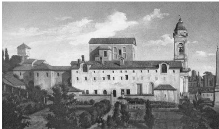
Fig. 24. Veduta dipinta da L. Dupré nel 1821 in cui risulta evidente il finestrone centrale fatto aprire nella biblioteca dopo la tamponatura delle finestre originali.
