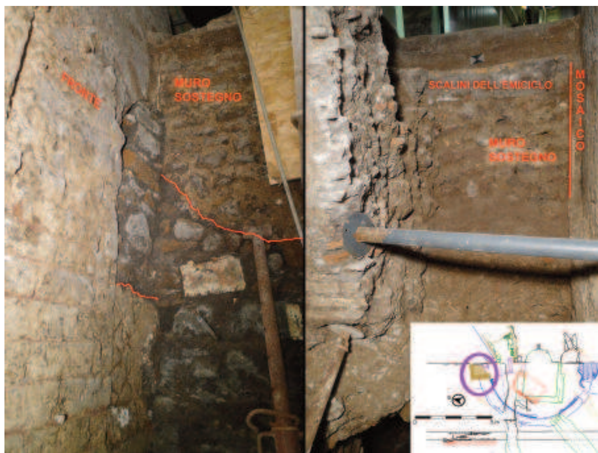
23. ROMA. BIBLIOTECA HERTZIANA. SOTTERRANEI: STRUTTURA DI SOSTEGNO DELLA MURATURA STRAPIOMBATA, FONDATA NEL RIPIERTO CHE PAREGGIAVA IL CALPESTIO AL LIVELLO DEL PORTICO SOPRAELEVATO OVEST
