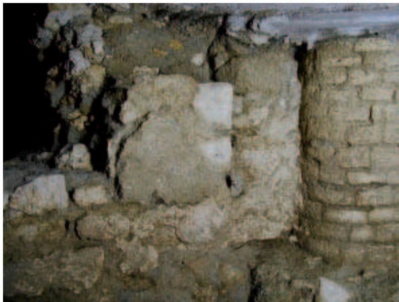
Fig. 4. Il punto di snodo tra due corpi di fabbrica: sulla destra l'ultimo pilastro della fronte continua, sulla sinistra l'angolata dell'edificio orientato diversamente. Notare lo spazio di risulta riempito con materiale di scarto e intonacato.
