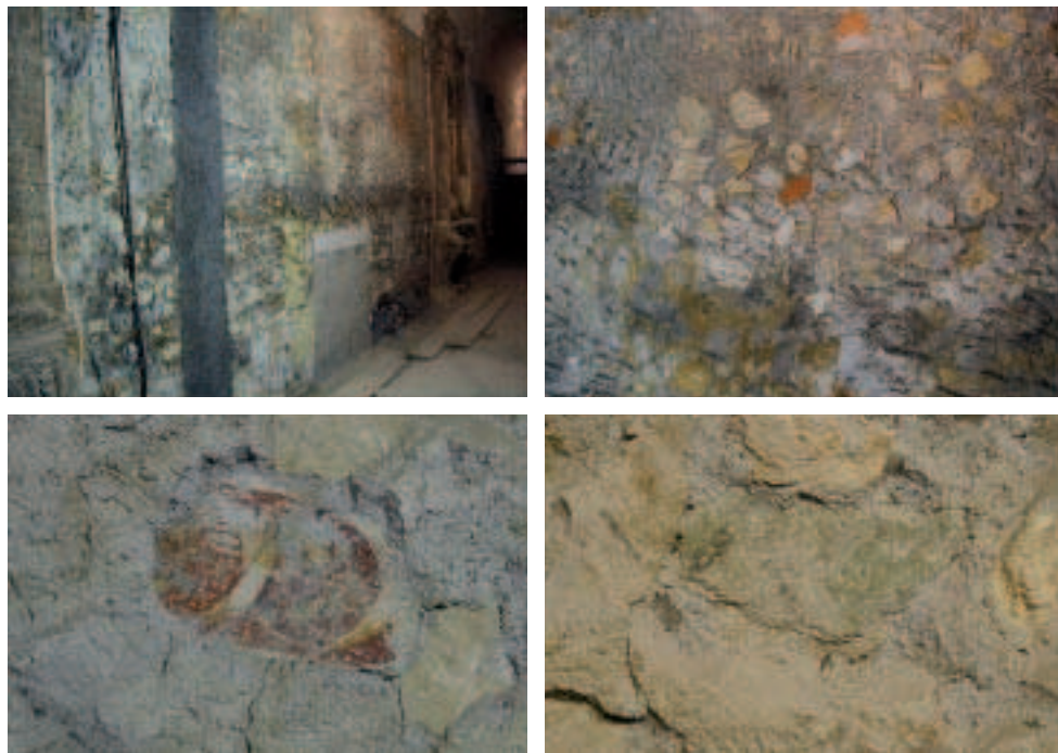
Fig. 22. Resti dell'intonaco decorato di prima fase, attribuibili a Luigi Karcher, della Manica Lunga, riutilizzati come "rincoccio" prima della stesura del nuovo rivestimento.
