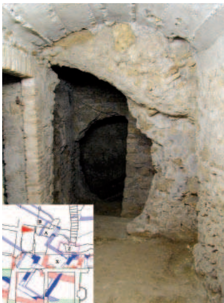
Fig. 21. Le fondazioni della scala monumentale realizzate contro terra e visibili in alto scoperte dopo la realizzazione del nuovo percorso d'accesso alle cantine.
