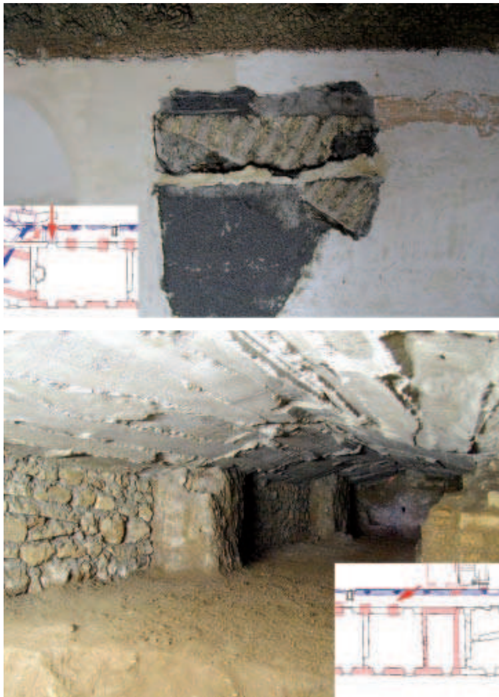
Fig. 11. In alto la porzione di ghiera medievale documentata sotto l'intonaco della Manica Lunga; in basso le fondazioni dei pilastri medievali, visibili sulla sinistra realizzate contro terra. La muratura che si vede tra le fondazioni è cinquecentesca.
