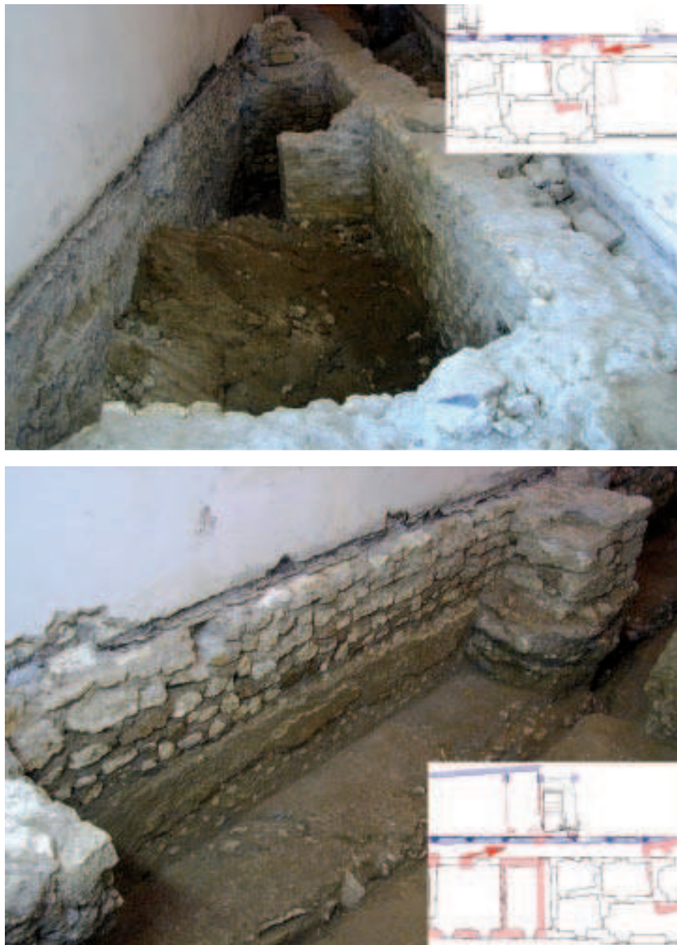
Fig. 12. In alto resti della struttura quadrangolare medievale rinvenuta tra la Manica Lunga e la sala della Caccia; in basso l'evidenza della stratigrafia archeologica, con la fondazione e la corrispondente fronte continua romana sopra le quali insiste un muro medievale anch'esso dotato di pilastri col medesimo ritmo dei più antichi. Ancora al di sopra la parete della Manica Lunga.
