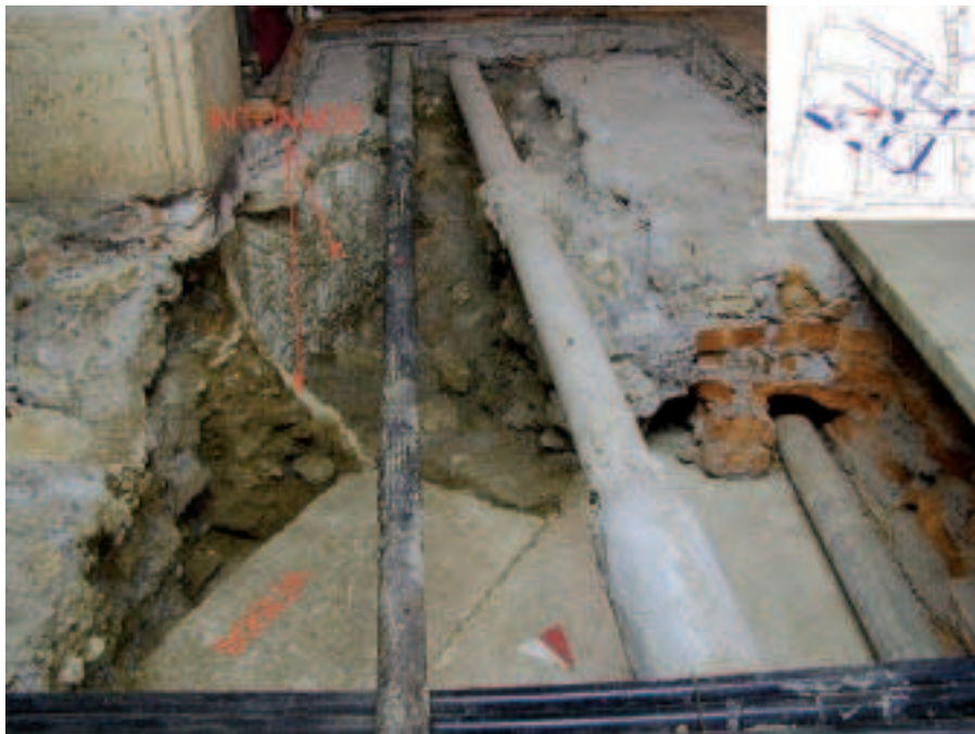
Fig. 6. Intonaco superstite senza il supporto murario della spalla di un vano porta.
