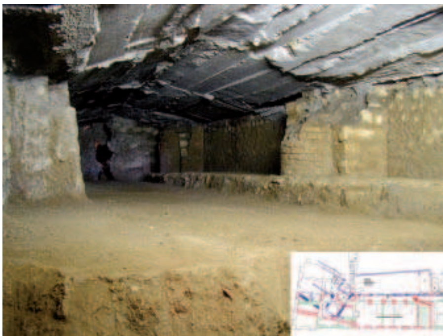
Fig. 7. La fronte continua ritmata da pilastri con la fondazione scoperta.
