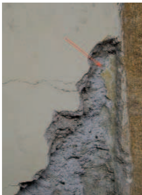
Fig. 22. Resti dell'intonaco decorato di prima fase, attribuibili a Luigi Karcher, della Manica Lunga, riutilizzati come "rincoccio" prima della stesura del nuovo rivestimento.
