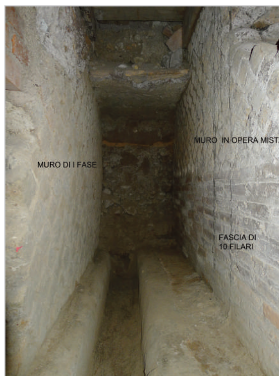
39. ROMA. TRINITÀ DEI MONTI. CASA D'ACCOGLIENZA: CANALETTA DI I FASE DOCUMENTATA SOTTO LA CAPPELLA. VISTA A NORD
