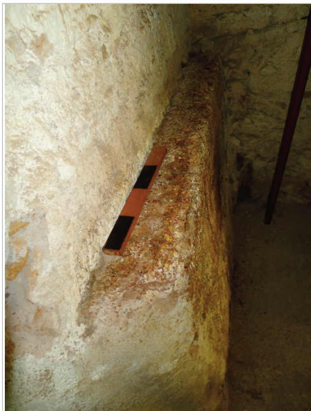
28. ROMA. TRINITÀ DEI MONTI. PORZIONE SETTENTRIONALE DELLA FONDAZIONE ROMANA RICONOSCIUTA NEL LOCALE k5, VISTA A NORD. PIANO DA CUI SPICCA LA MURATURA CINQUECENTESCA
