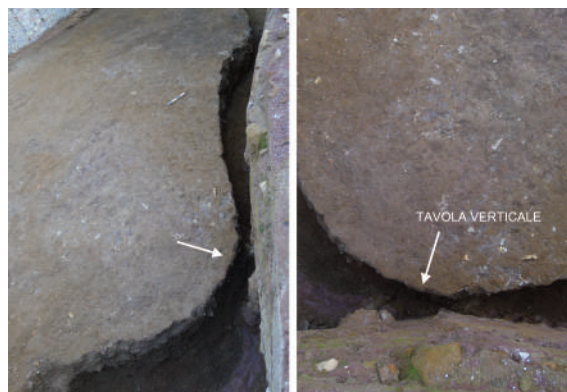
66. ROMA. VILLA MEDICI. FALEGNAMERIA: I TAGLI A MEZZALUNA PER LA COSTRUZIONE DELLA CISTERNA ROMANA
