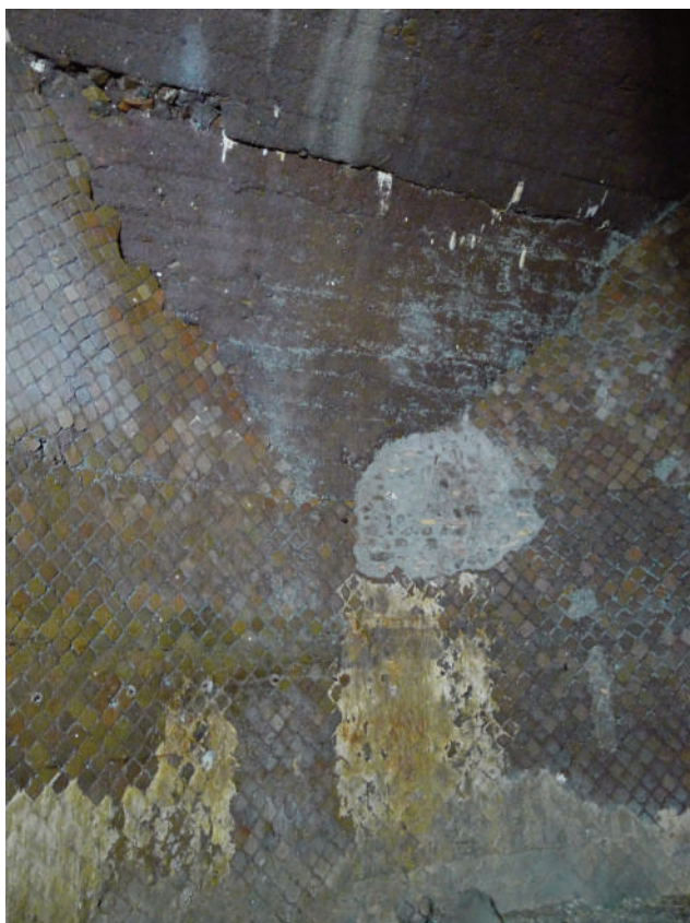
8. ROMA. TRINITÀ DEI MONTI. SOTTERRANEI: ABSIDE ROMANA (1a) COPERTA DALLA VOLTA A BOTTE CON ASSE LONGITUDINALE NS. LA SEZIONE SECONDO LA DIRETTRICE S'INCUNEA PROFONDAMENTE NEL MURO CURVO, CREANDO LINEE DI INTERSEZIONE TRA DUE SEMICILINDRI GIACENTI SU PIANI PERPENDICOLARI
