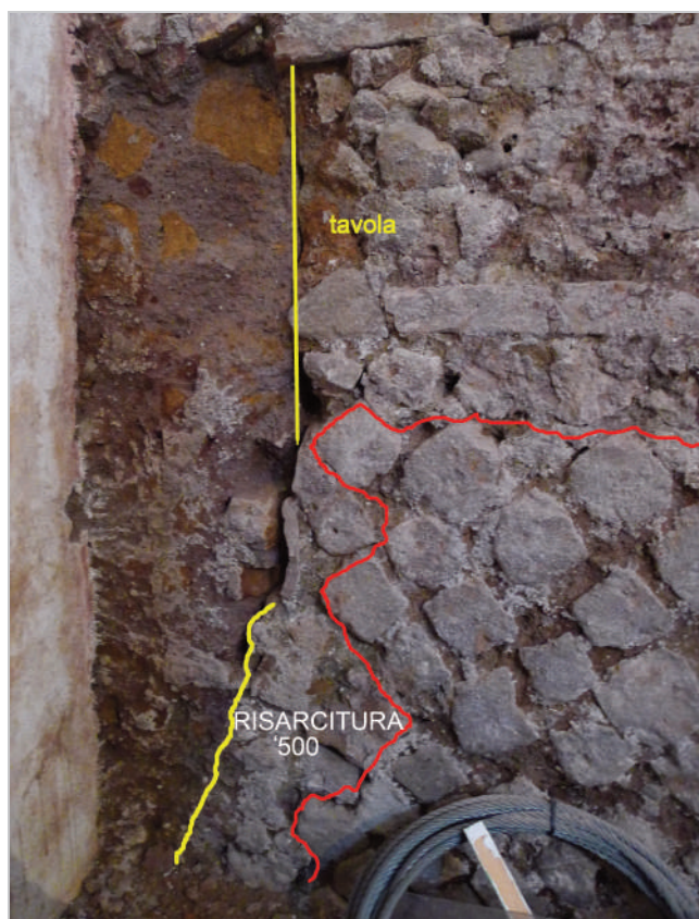
36. ROMA. TRINITÀ DEI MONTI. CASA D'ACCOGLIENZA: CONTATTO TRA IL MURO MERIDIONALE DEL LACUS (A SIN.) E MURATURA IN RETICOLATO DI GROSSO MODULO TAGLIATA
