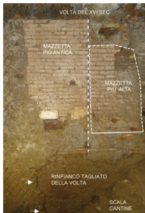
12. ROMA. TRINITÀ DEI MONTI. SOTTERRANEI: MURO SETTENTRIONALE DEL VANO 11 CON TRACCE DI PORTE DI FASI DIFFERENTI
