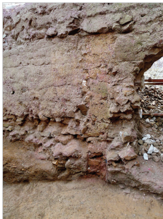
65. ROMA. VILLA MEDICI. FALEGNAMERIA: IMPRONTA DI TAVOLA VERTICALE NELLA FACCEIA ORIENTALE DELL'US 14 A RIDOSSO DELL'ANGOLO TRA MURATURA CURVA E MURO RETTILINEO DELL'AMBIENTE QUADRANGOLARE
