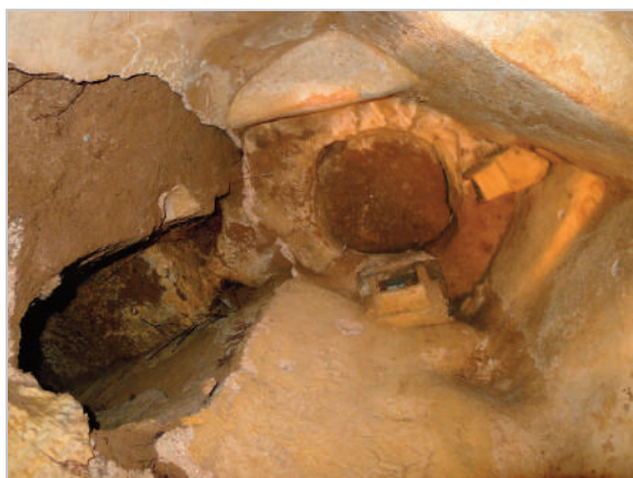
47. ROMA. VILLA MEDICI: VISTA DAL BASSO DELL'INEDITO POZZO REPUBBLICANO. SI DISTINGUONO I DOCCIONI A SEZIONE QUADRATA E, SULLA SIN., LA CANALETTA SCAVATA NEL TUFO
