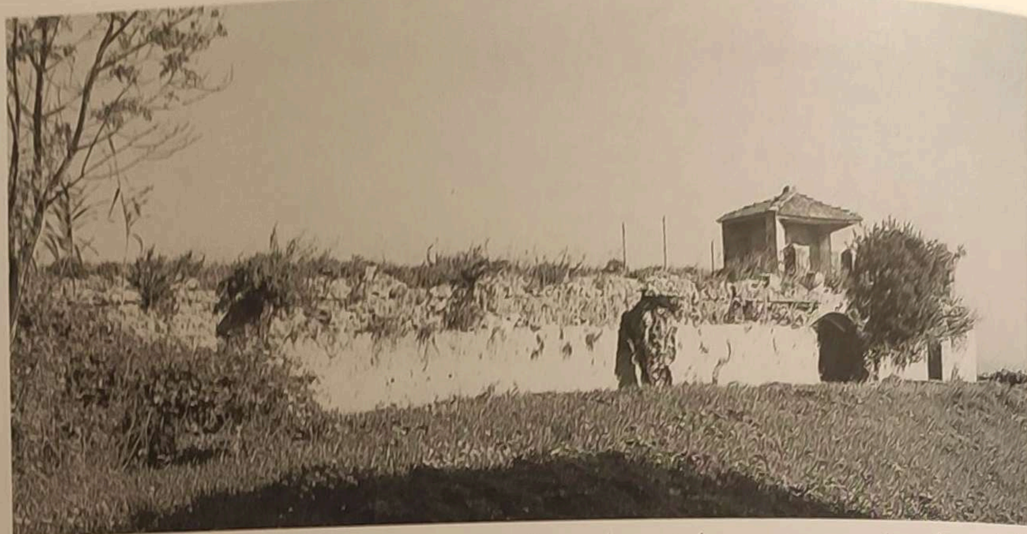
Fig. 8. Veduta del muro sud della terrazza superiore; tale muro ha spessore maggiore di tre piedi poiché risponde ad esigenze statiche relative al pendio diverse dal resto della struttura sostruttiva. Sulla destra la c. d. "torretta dei quattro venti".
