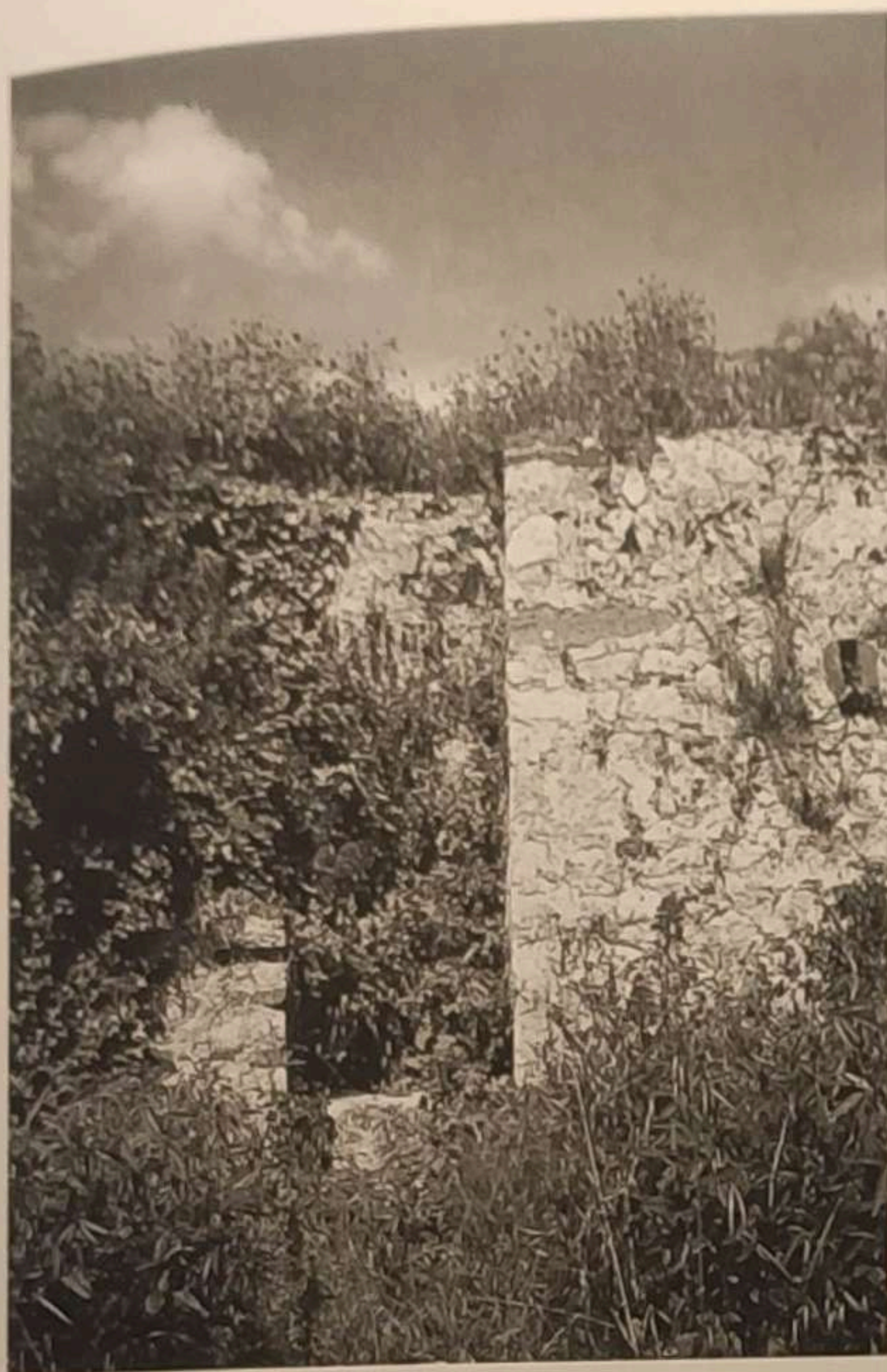
Fig. 15. Scala di raccordo tra i due terrazzamenti costruita insieme al restauro del muro est della terrazza superiore.
