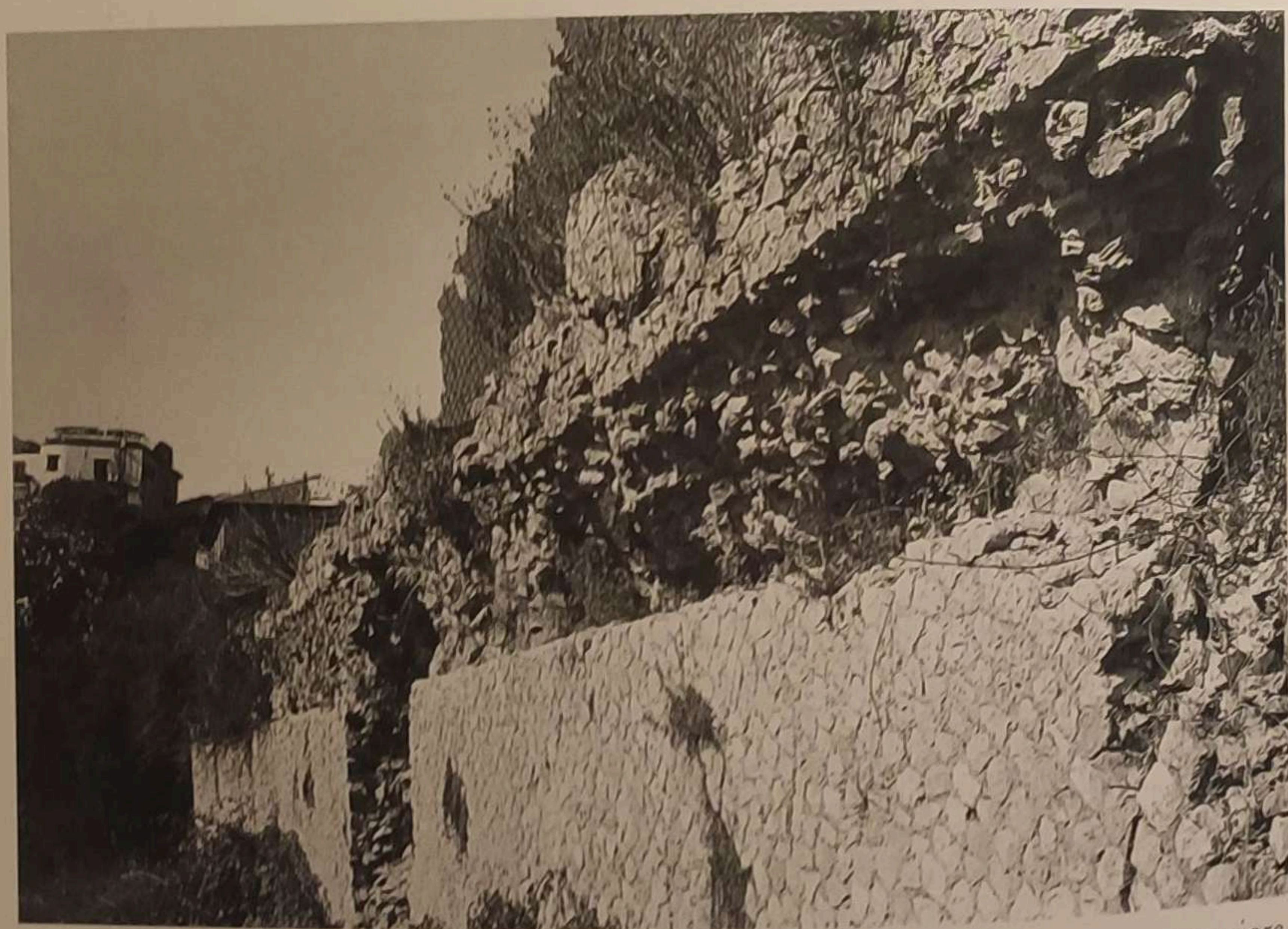
Fig. 9. La traccia regolare che percorre il perimetro della sostruzione della terrazza superiore. Nella foto il muro Sud.
