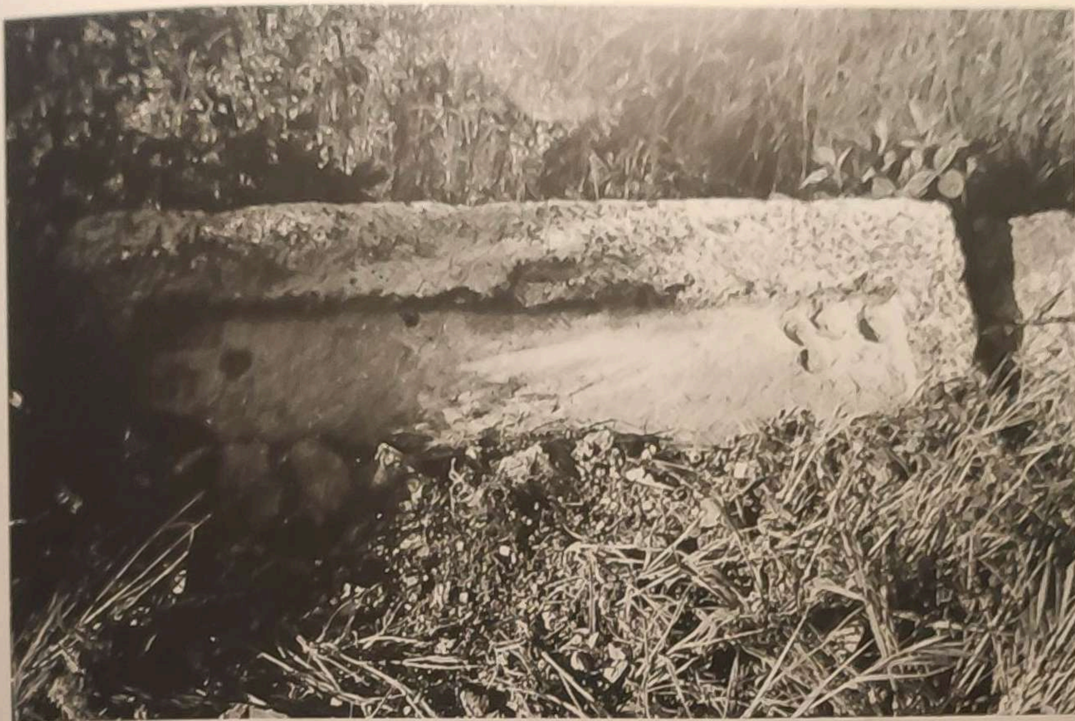
Fig. 26. Soglia posta a ricostruire l'allineamento del muro sostruttivo sud.
